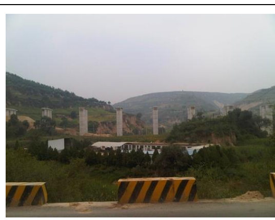
(圖 15) 在回程路上的工地
