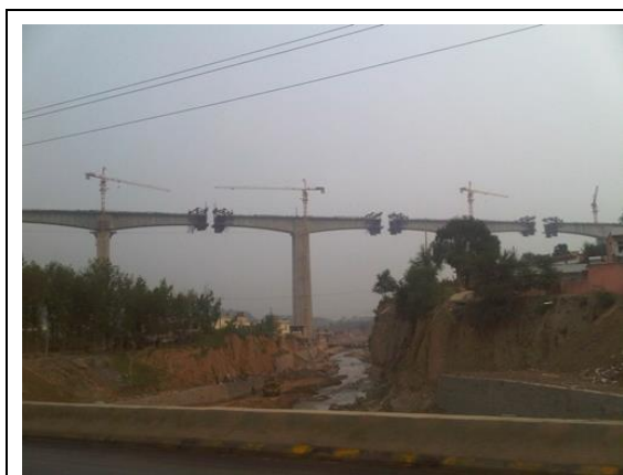
(圖 15)在回程路上的工地
