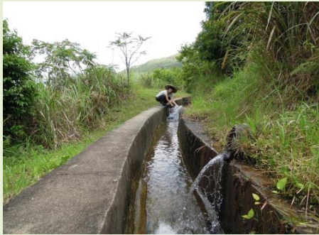
收集山泉，引入輸水道
